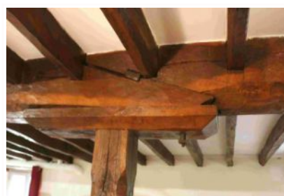
Assemblage de poutres en trait de Jupiter
